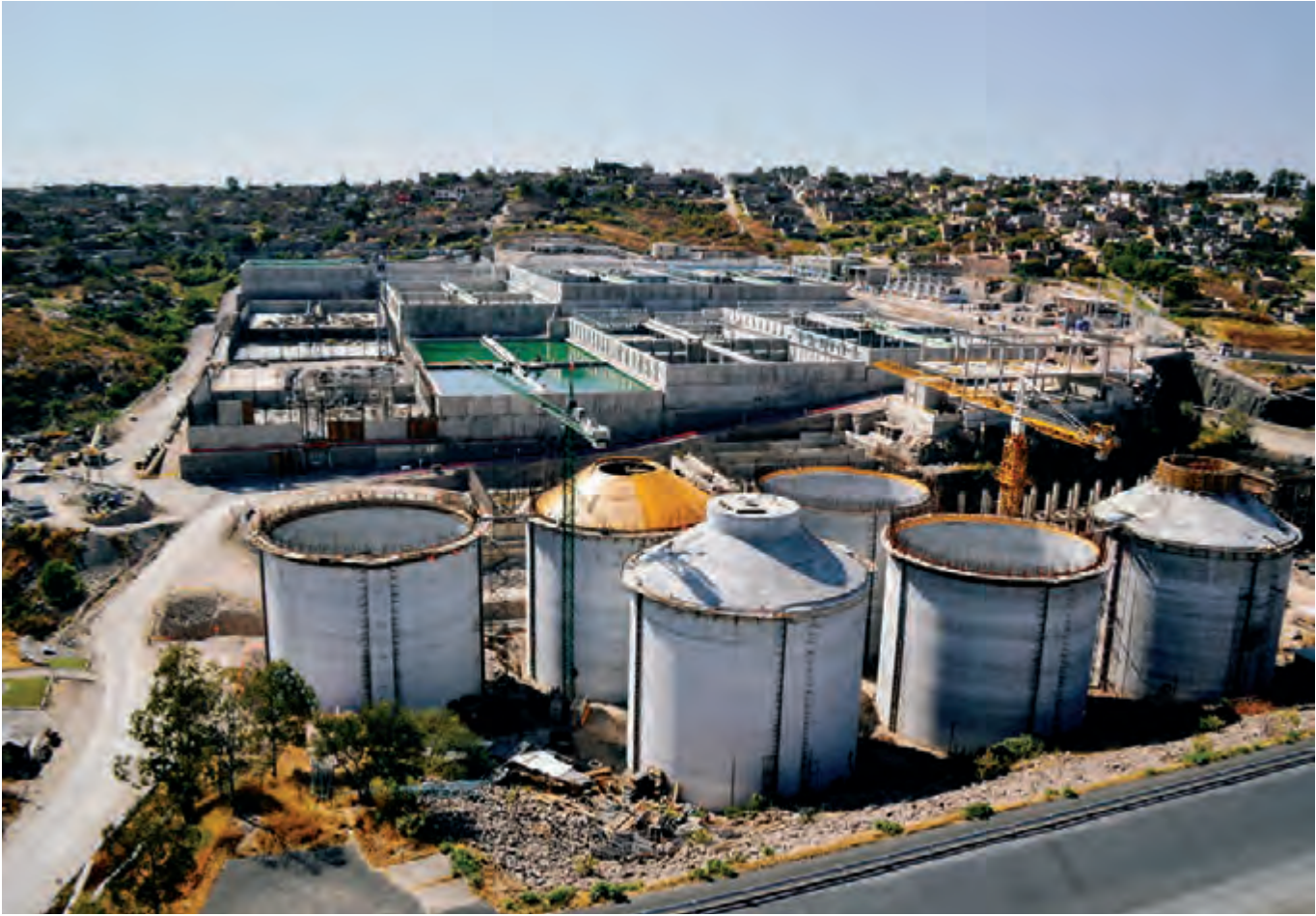
↘ 2013 _ Planta de Tratamiento de Aguas Residuales Agua Prieta
